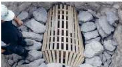
1. All'interno della camicia in muratura si costruiva la camera di combustione sormontata da una volta in pietra calcarea.
