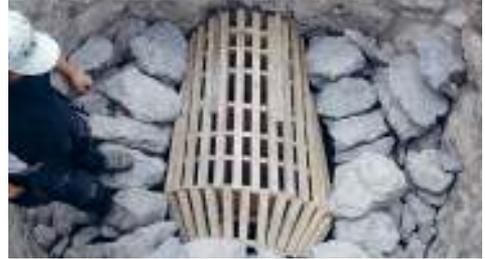
1. Im Innern wurde längs der Umfassungs-Trockenmauer eine gewölbte Brennkammer aus Kalkstein gebaut. Stein nach Stein wurde der Ofen sorgfältig gefüllt: die größten Steine wurden näher ans Feuer gelegt.
