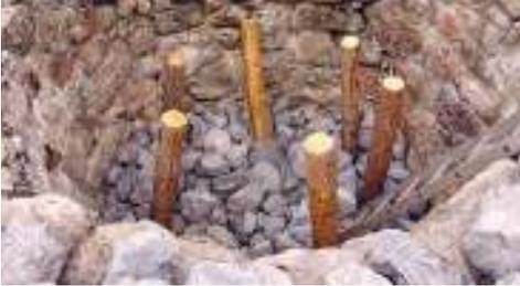
2. Holzstangen von ca. 15-20 cm Durchmesser wurden zwischen die Steine gesteckt; sie verbrannten nach dem Anzünden so, dass Hohlräume entstanden, durch welche die Luft kaminartig abziehen konnte.
