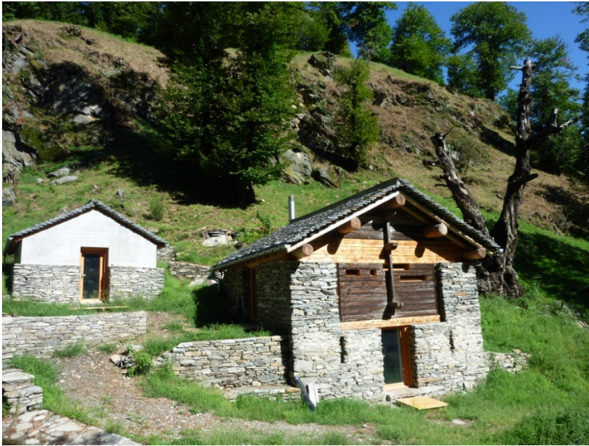
Centro didattico Nosáll-Rolétt: Cucina (a sinistra) e Refettorio (a destra)
